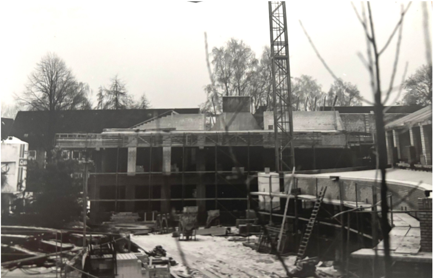
Bauarbeiten an der GeFa: Neubau der jetzigen Jahrgänge 6 (oben) und 8 (unten) sowie der Bücherei (rechts)
